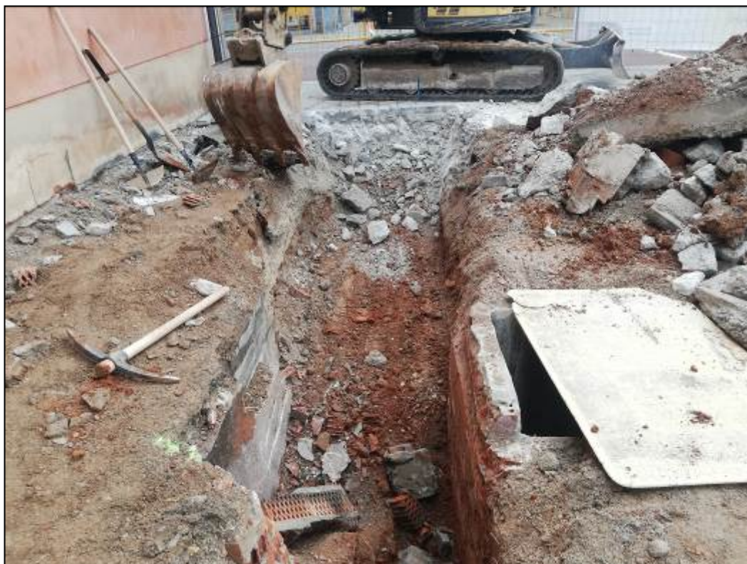
Fotografia 5. Tasques d'obertura de la rasa
