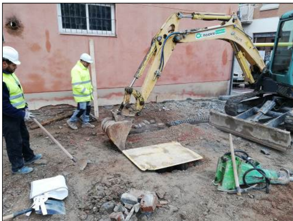
Fotografia 4. Detall dels treballs realitzats.
